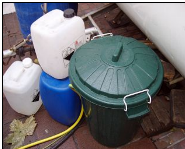
Abbildung 5: Beispiel für eine völlig unzureichende Trinkwasserversorgung. Der Behälter ist kein Trinkwasserkanister, der Deckel offen, der Schlauch entspricht nicht den DVGW- und KTW – Vorgaben.
