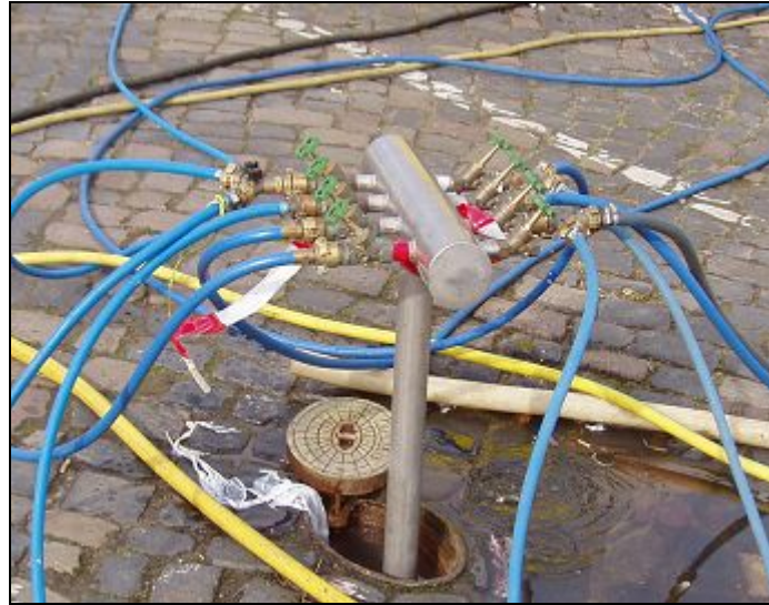
Abbildung 6: Standrohr mit insgesamt 8 Anschlüssen und geprüften Trinkwasserschläuchen
